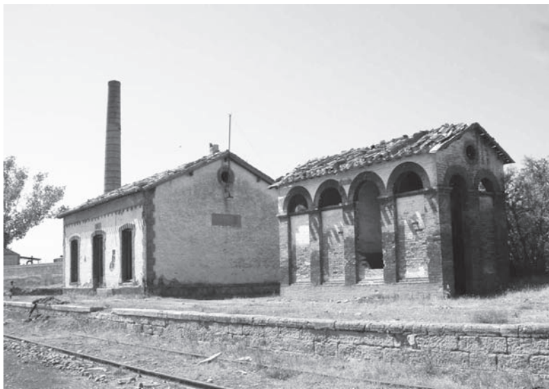
Actual estado de la Estación de tren de Caniles
