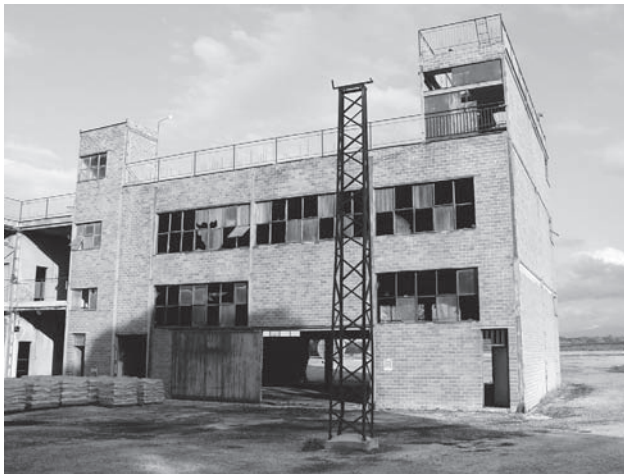
Estado actual de uno de los laterales de la fábrica
